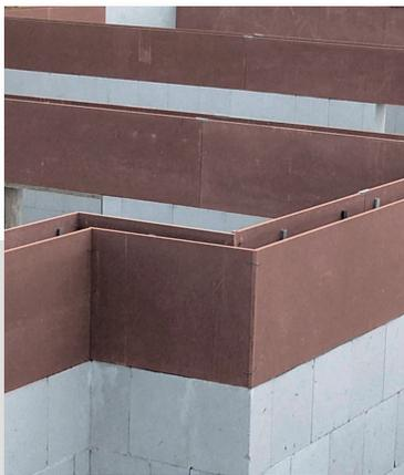
**1** Bauschalung aufsetzen, mit Richtklammern oder Schaum oder in Mörtel aufbringen.
