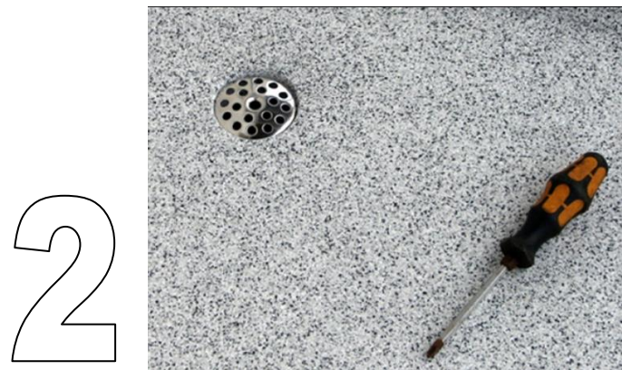
SBS UG - Ablaufgarnitur einlegen und verschrauben
