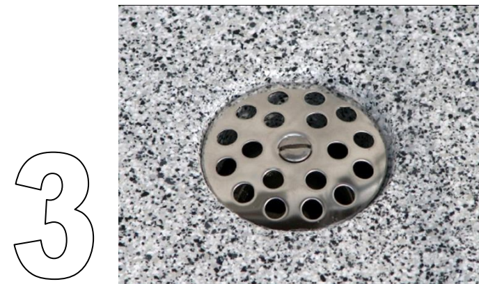
SBS UG - Ablaufgarnitur fertig eingebaut
